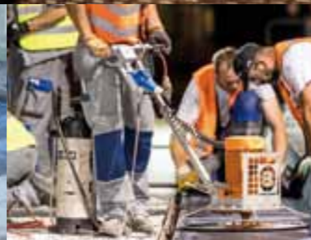
Glätten für die plane Oberfläche.
