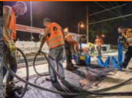
Ebener Einbau mit der Rüttelbohle.
