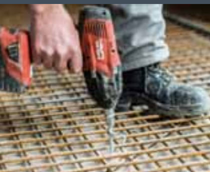
Basis: Engmaschige Armierung auf tragfähigem Untergrund.
