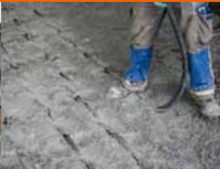
Kontrollierte Verdichtung, engmaschig mit Rüttelflasche ausgeführt.
